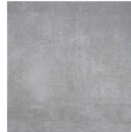
Бетонное покрытие скейтпарка
